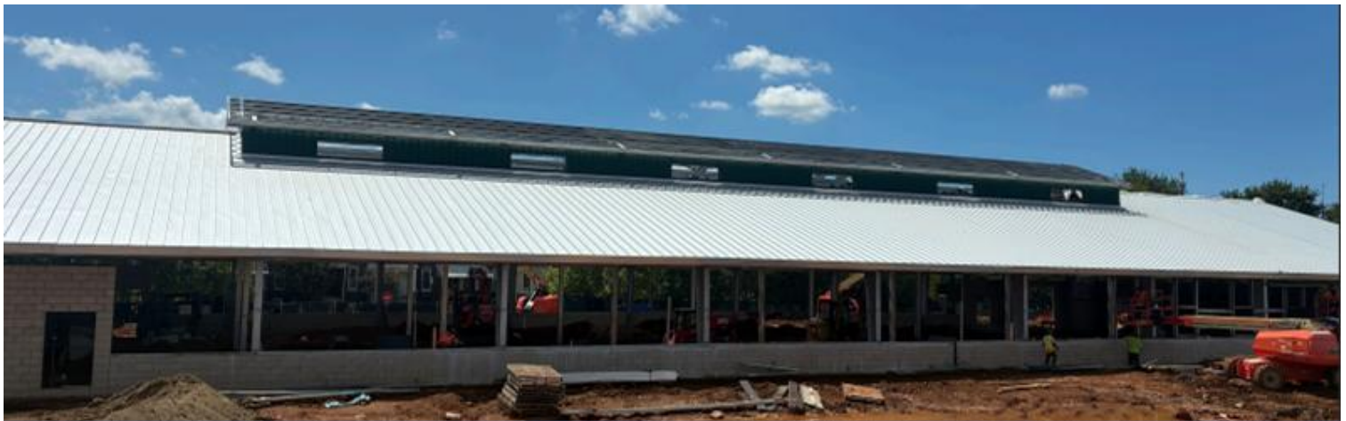
La instalación del techo de las caballerizas Stakes Barn está cerca de completarse a cargo de THG Companies, Omega Contracting y MTD Erectors.
