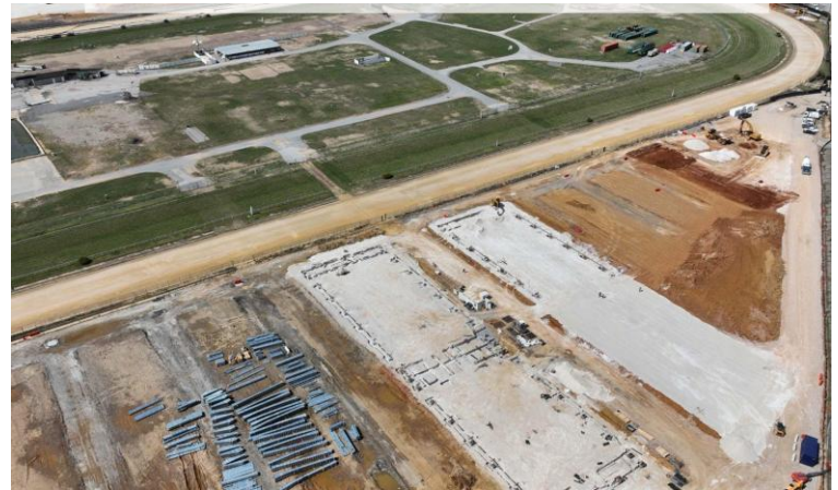
De Túnel a Backstretch (zona trasera): Estas fotos aéreas del 25 de marzo de 2026 destacan el trabajo crítico de excavación del Túnel y la Península de Park Heights mirando hacia el noreste (izquierda), junto con las placas de cimentación y el área de almacenamiento de acero del Backstretch mirando hacia el noroeste (derecha)
